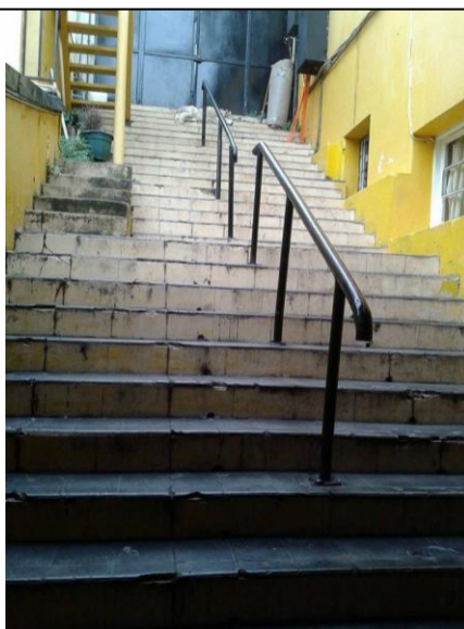
Foto N°4. Escaleras y vidrios (ventanas)
