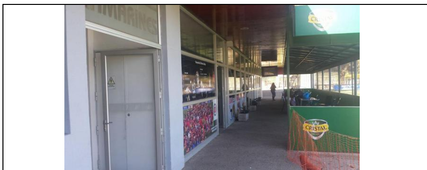
Foto N° 8. Zona de riesgo por vidrios existentes en el lugar
