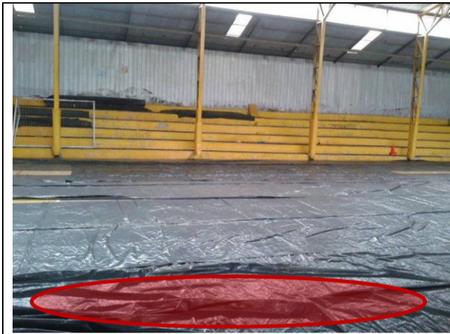
Foto N°1. Costado ingreso al gimnasio
